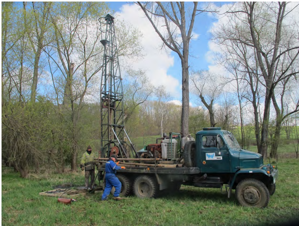
Obr. 3. Provádění vrtu JD1.
